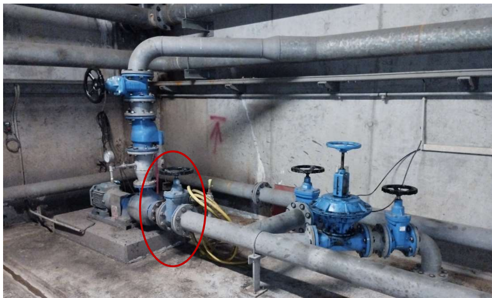
Válvula de compuerta manual de bomba de fango primario.
