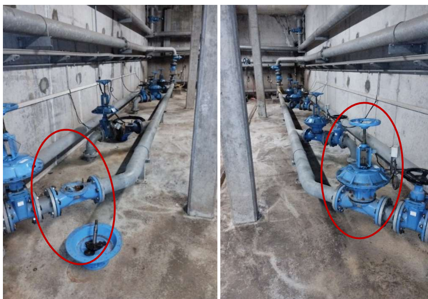
Válvulas de membrana de accionamiento neumático.
