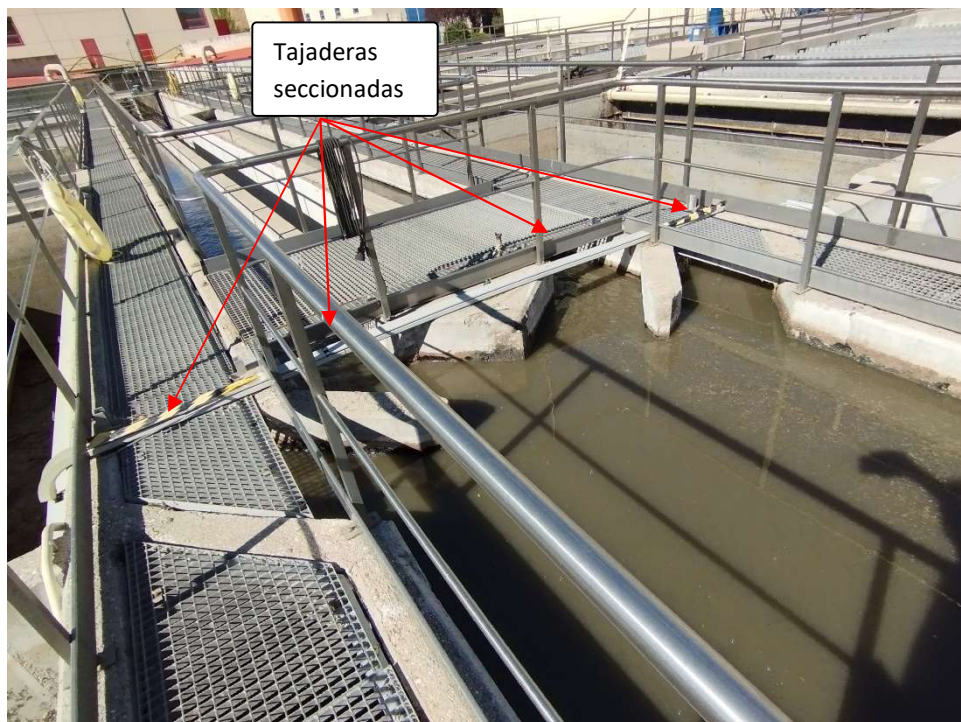
Tajaderas actuales de entrada a decantación primaria. Zona 2.
