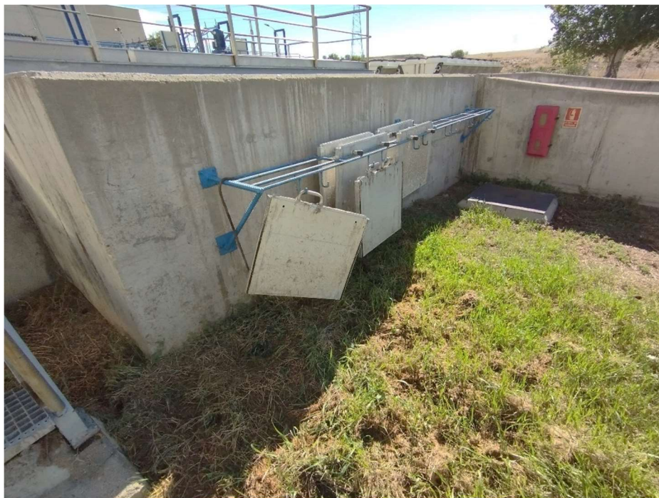
Tajaderas de entrada a decantación primaria.
