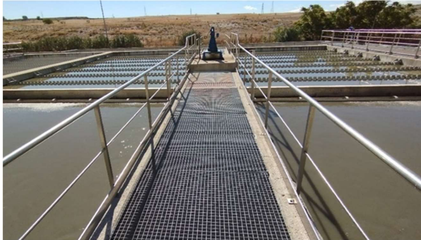
Pasarela intermedia decantador primario.
