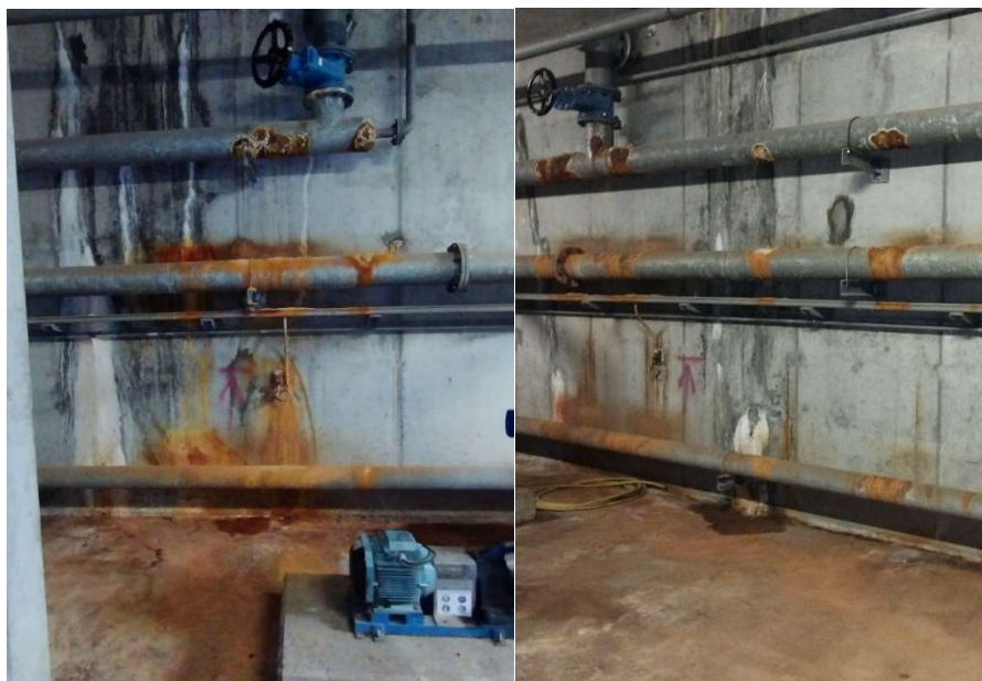
Tuberías en galería corroídas a sustituir.
